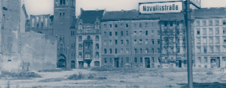
Blick in die Borsigstrasse nach dem Zweiten Weltkrieg mit Kriegsschäden, von denen auch der Gebäudekomplex Borsigstrasse 5 betroffen ist. View of Borsigstrasse after the Second World War, showing war damages, including the building complex of Borsigstrasse 5. Aus Erinnerungen an das Sprachenkonvikt, Berlin 2017.
